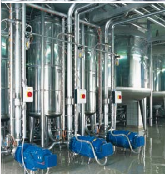
Prozess-Tanks, Bitburger Brauerei, Bitburg
